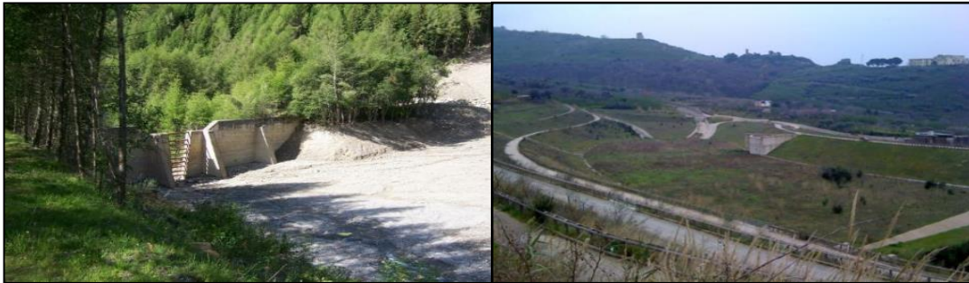
Figura 75. Ejemplos de obras de mitigación para la retención de la porción sólida transportada por un lahar: a) trampa de sedimentación y b) alberca de sedimentación en el volcán Vesubio (Sarno, Italia).
