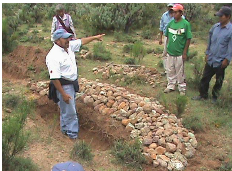
Imagen 7.8. Construcción de zanjas con reforzamiento de piedra para propiciar infiltración
